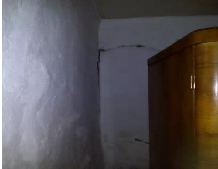
2 sz. kép: Repedések a falon
