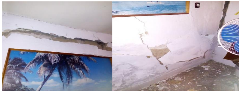
3.a és 3.b képek: Repedések és a kezdődő omlás
