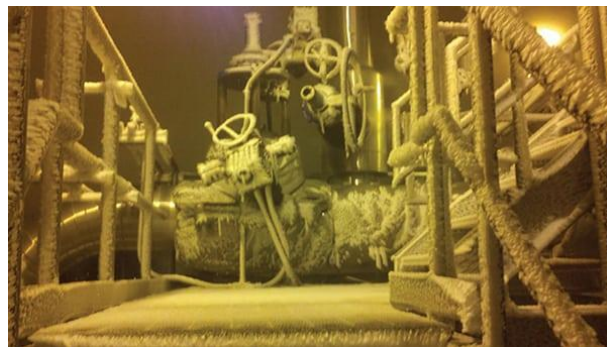
2011. februárjában, Texasban az extrém hideg időjárás közel 15 MW összteljesítmény kiesést okozott egy gázerőműben [12]
