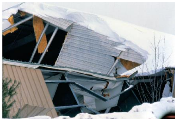
Könnyűszerkezetes építmény összerogyása hóteherből [9]
