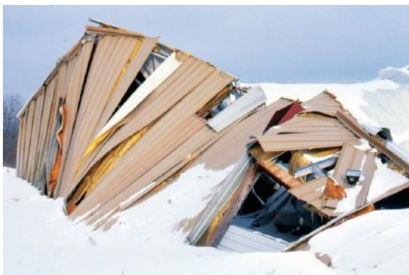
Könnyűszerkezetes építmény összerogyása hóteherből [9]
