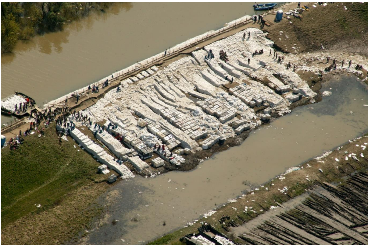
2. kép: Hármaskörös 0+700 fkm bordás megtámasztás 2006. évi árhullám alkalmával Forrás: Országos Műszaki Irányító Törzs (Vizy Zsigmond)
