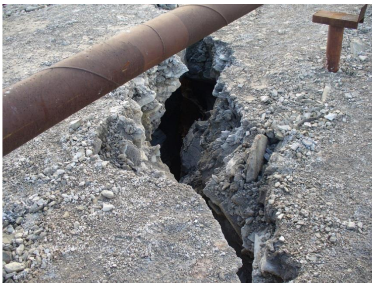
3. sz. kép: A X. sz. kazetta gátjának repedése. Készítette: a szerző
