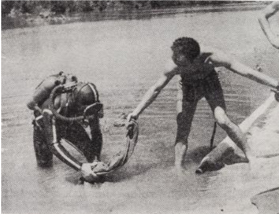
Búvár általi fólia fektetés (Dégen, 1996)
