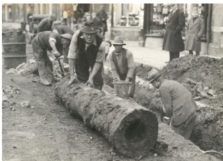
1. kép Szilfa vízvezeték Gosport főutcáján (1936) [1]
