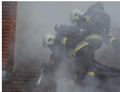
6. kép Tetőbontás tüzesetnél, fotó: TMKI [6]
