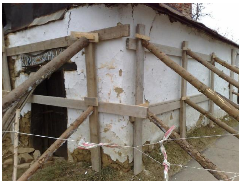
8. kép: Dúcolás, támasztás (forrás: [5])
