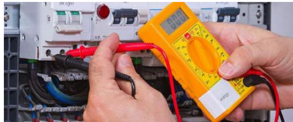
11. kép Érintésvédelmi felülvizsgálat [11]
