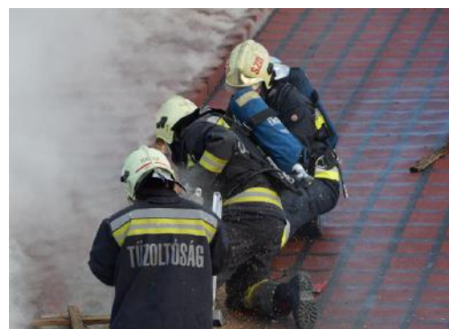
7. kép Tetőbontás tüzesetnél, fotó: TMKI [7]
