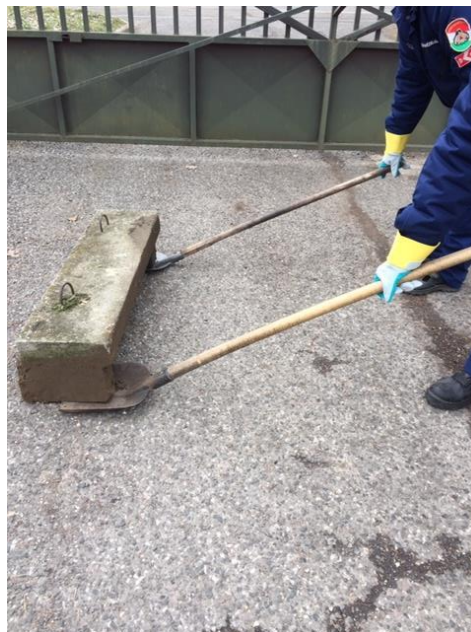
4. kép: Fém lapát használata húzásnál és csúsztatásnál, készítették a szerzők.
