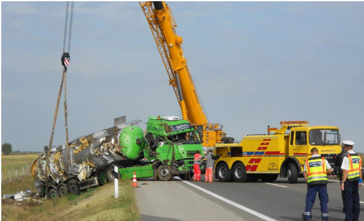
4. kép. A tartányos szerelvény egyidejű emelése (tartása) és húzása. Készítette: Almási Csaba (2012)
